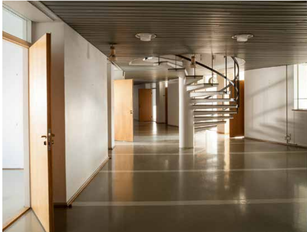
Ylimmän kerroksen kierreporras on säilynyt alkuperäisessä asussaan.
