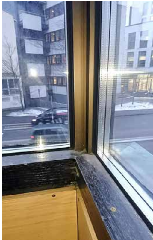
Ulkonurkan ikkunat on vaihdettu umpiolasielementeiksi.
